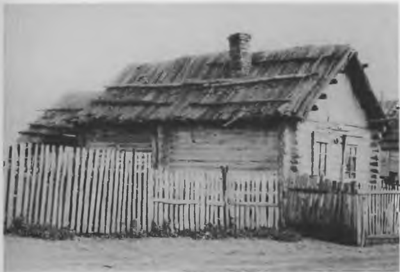
Рис. 80. Срубная изба-сени. Двухскатная коньковая крыша, покрытая лубом. Начало XX в. Д. Карасу. Республика Татарстан. 1975 г.
