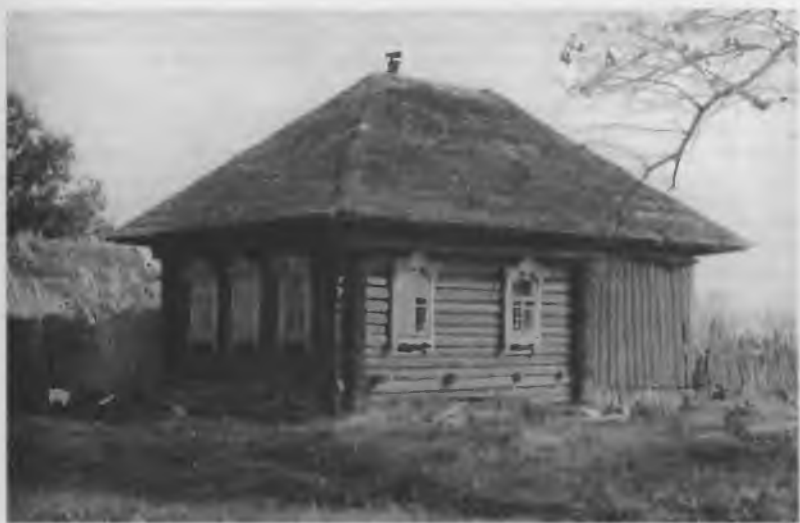
Рис. 84 Дом с шатровой крышей. Покрытие из щепы (дранки). Д. Атенино. Мордовия. 1981 г.
