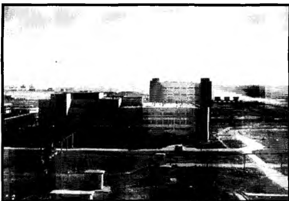
Часть научно-исследовательского комплекса в Степногорске: вид из окна 221-го здания. На переднем плане перед зданием, где размещались аэрозольные взрывные камеры, видны бункеры для заправки и сборки бактериологических боеприпасов. В более высоком здании на заднем плане высушивали вирус сибирской язвы
