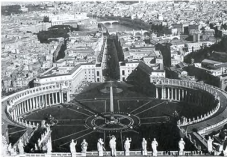
4. Вид «восьмиугольного эллипса» на площади Сан-Пьетро с крыши Базилики.
