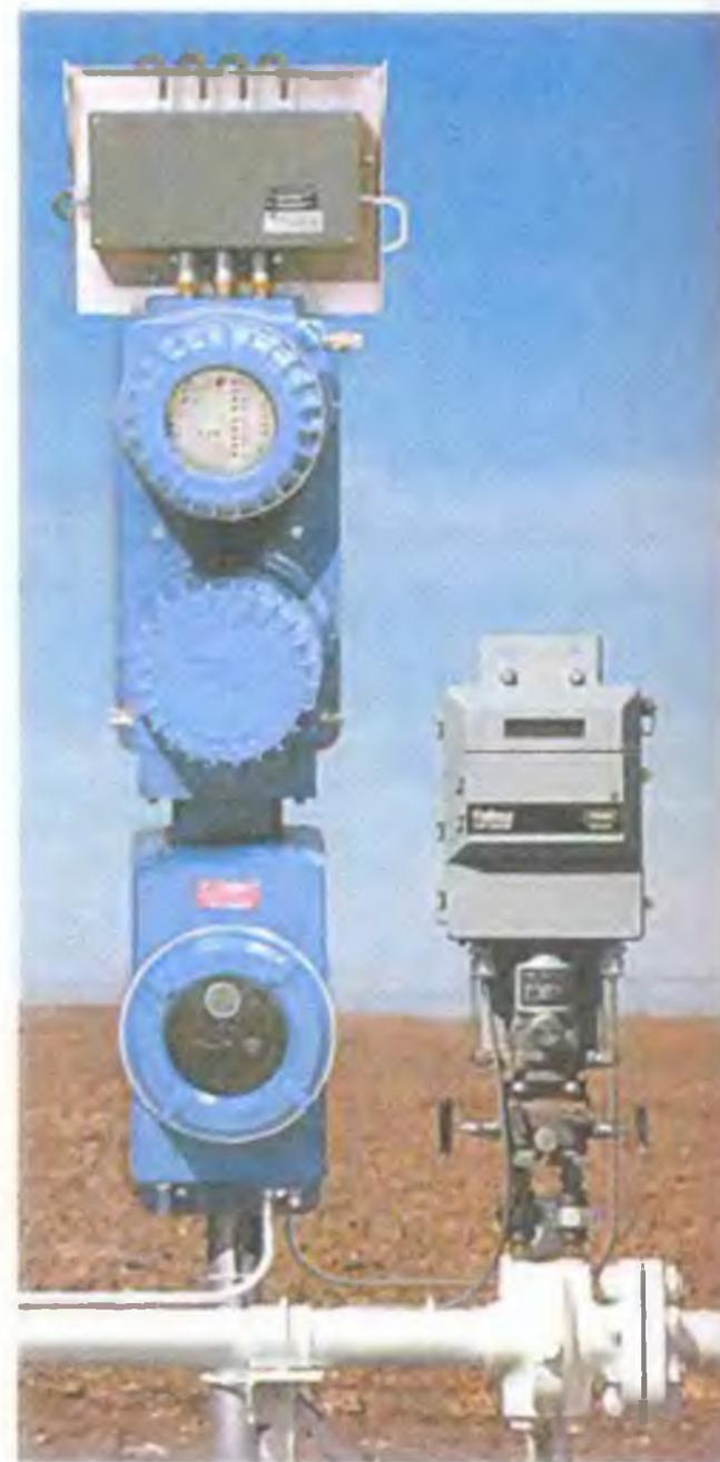
Рис. 4. Современный узел замера расхода газа: слева – поточный газовый хроматограф; справа – счетчик газа с корректором.
