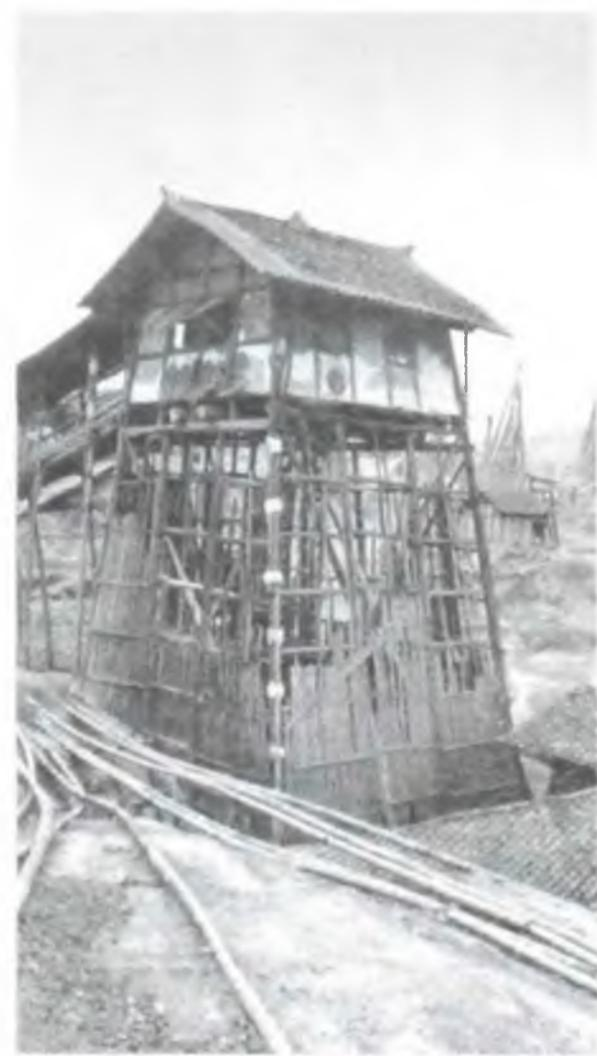
Рис. 1. Буровая вышка в Китае, в провинции Сычуань (на переднем плане газопроводные трубы из бамбука).
