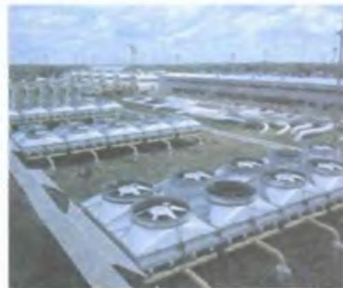
Рис. 7. Блок воздушных холодильников компрессорной станции.
