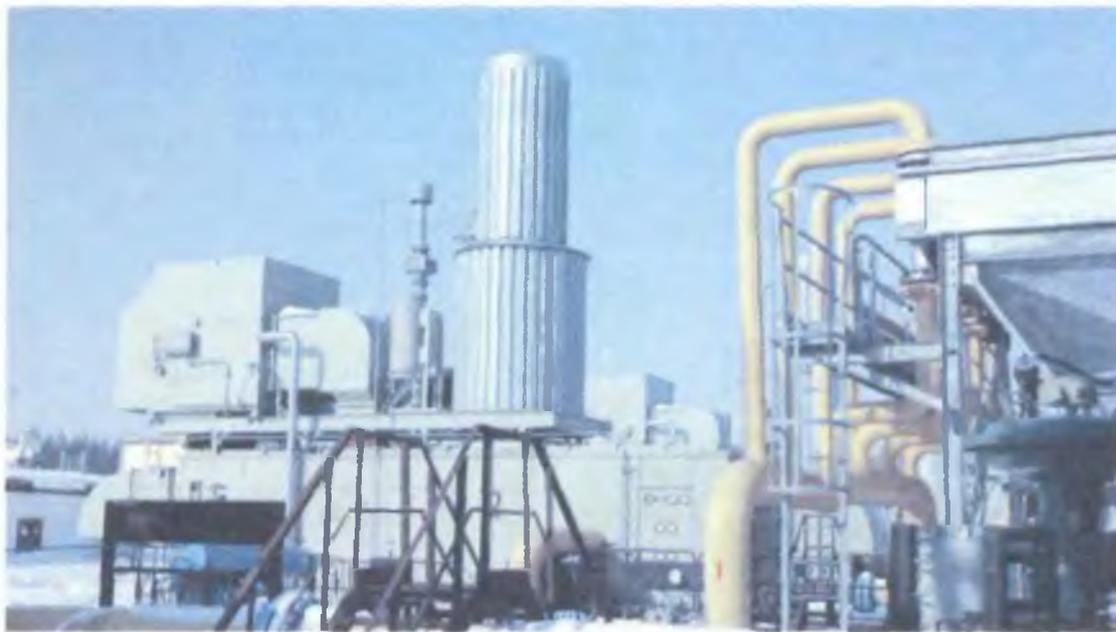
Рис. 8. Технологические аппараты очистки и осушки газа на Касимовском ПХГ.
