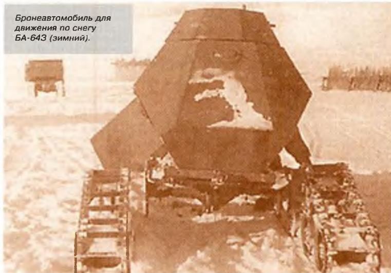
Уже после выпуска первых серийных машин конструкторы занялись улучшением боковой устойчивости БА-64. С этой целью колея броневика была расширена с 1240 мм до 1446 мм, для чего было использовано шасси автомобиля ГАЗ-64Б, в переднюю подвеску добавили два амортизатора и внесли еще целый ряд изменений. В конце октября
