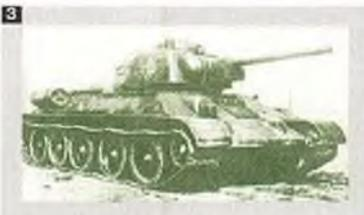
Для улучшения динамических качеств танка вместо четырехступенчатой коробки передач стали устанавливать пятиступенчатую. Масса танка выросла до 31 т.
