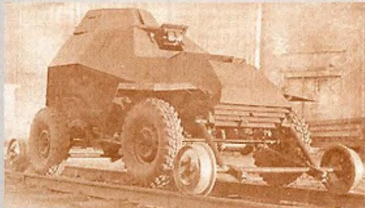
Железнодорожный вариант бронев автомобиля БА-64.
