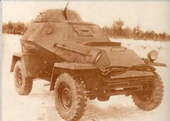
Бронеавтомобиль для движения по снегу БА-64З (зимний).
