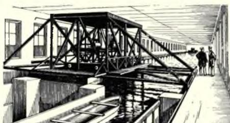
Буксировочная тележка для испытания моделей в Петербургском опытовом бассейне
