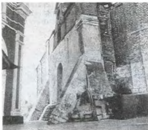
Церковь Иоакима и Анны. Фрагмент белокаменной стены. Конец XIV в.
