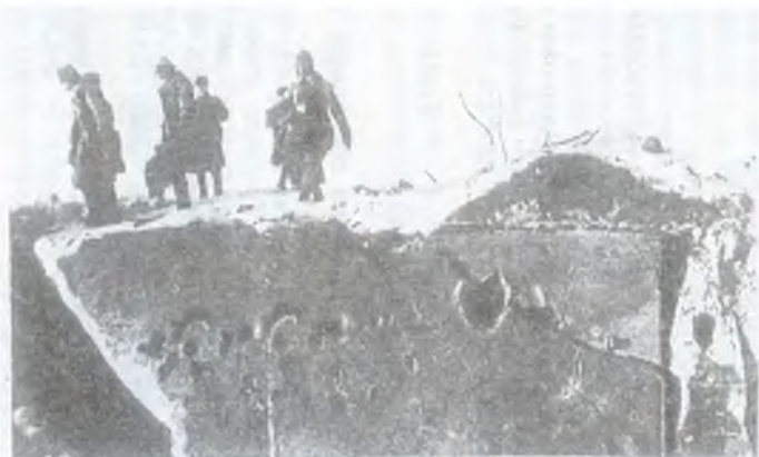
Финская ДОТ. На бронеплитах видны следы попадания снарядов советской артиллерии
