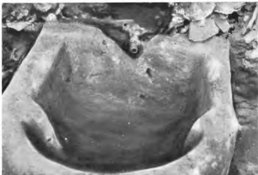
Рис. 148—149. Баня (Красная галата) в Болгарах. Вверху — печь, внизу — каменный водоем с краном.
