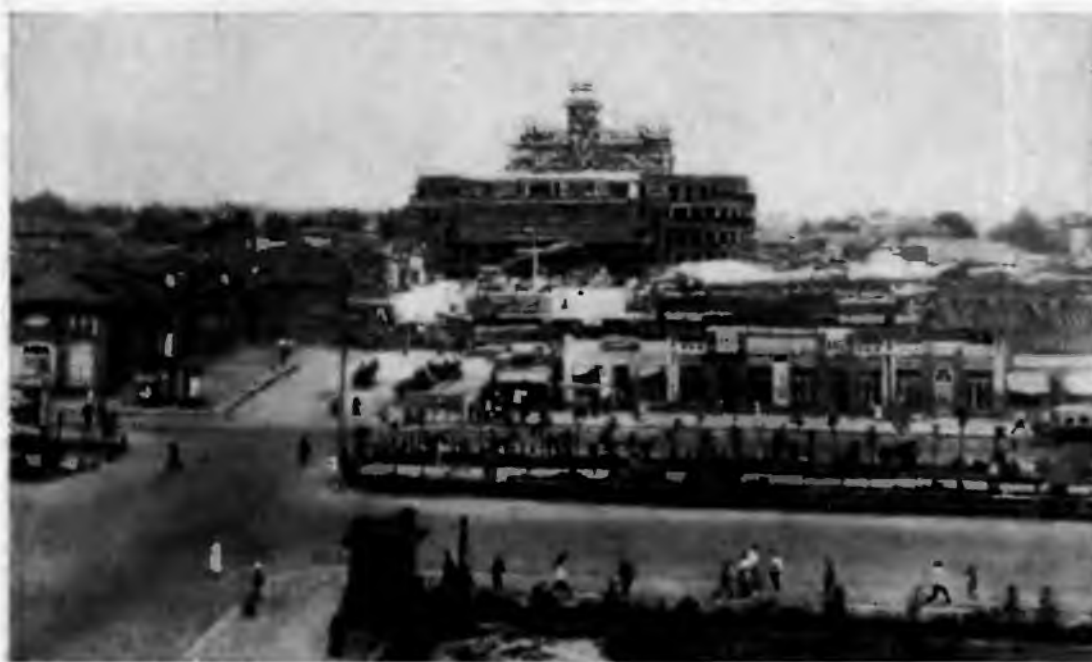
Строительство театра оперы и балета в Новосибирске. 1933 г.
