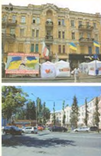
Здание Государственной пенитенциарной службы Украины на ул. Мельникова, 81 в Киеве
