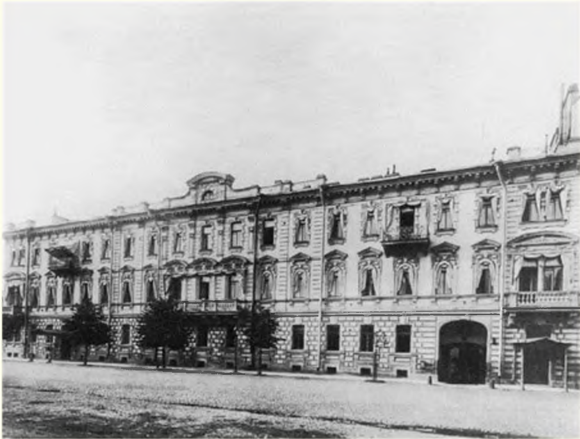
Здание штаба Отдельного корпуса жандармов (Санкт-Петербург)
